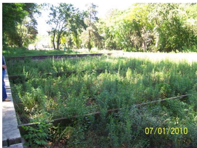
57 – Sistema Imhoff de Tratamento de Esgotos – Leitos de Secagem
