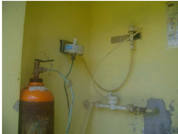
7 – Cloração do Sistema Hidráulica
