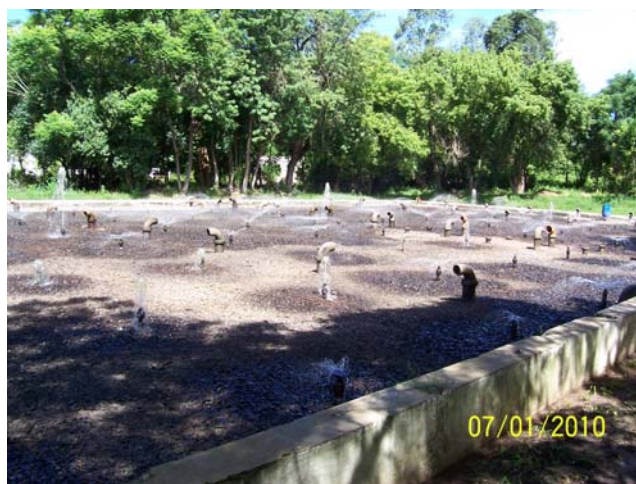
56 – Sistema Imhoff de Tratamento de Esgotos – Filtro Aeróbio
