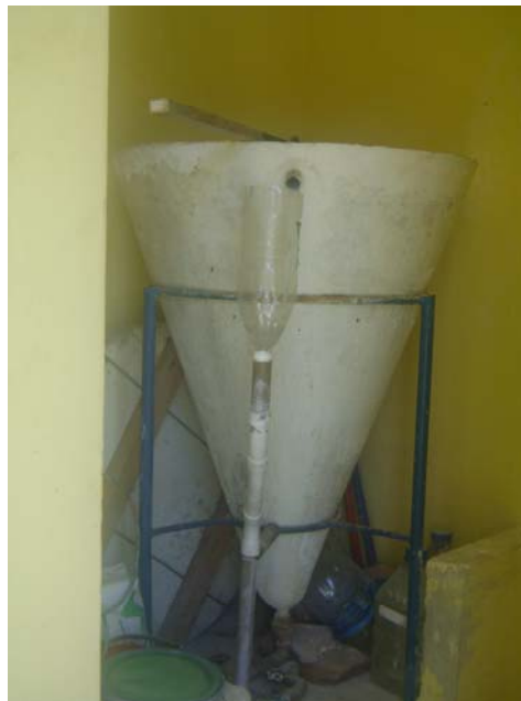
8 – Fluoretação do Sistema Hidráulica
