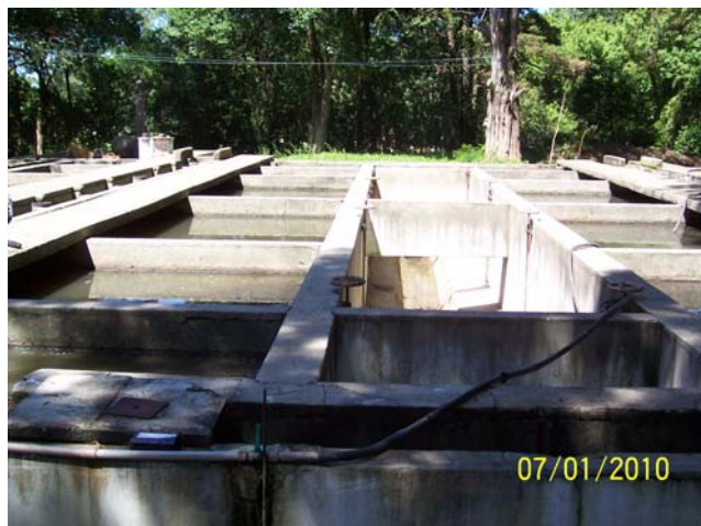
55 – Sistema Imhoff de Tratamento de Esgotos – Tanques Imhoff
